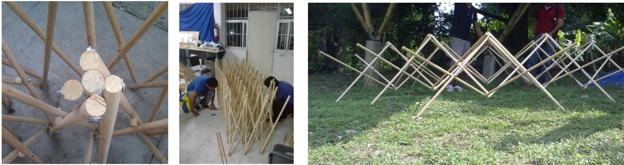
Figura 29. Se muestra las fases de manufactura del modelo bidireccional de la cubierta plegable, y se verifica su despliegue plegable. Fuente: Fotos experimentales (Morales, 2014).
