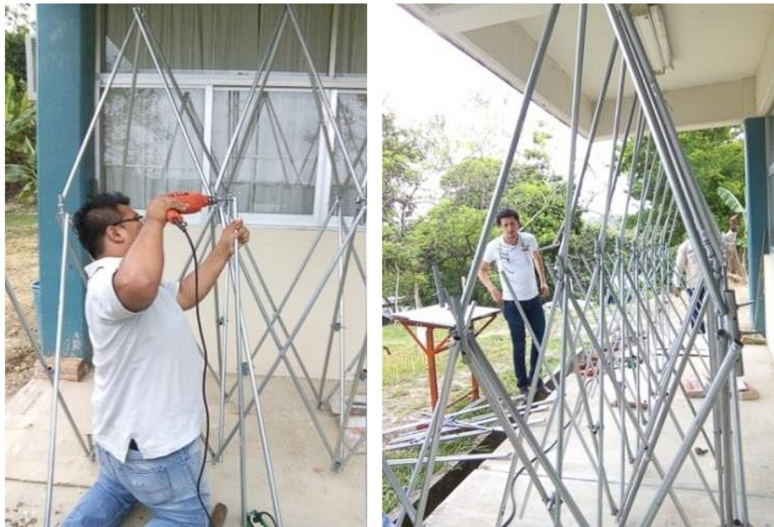
Figura 21. Se realiza el segundo bloque de arco para la estructura plegable. Fuente: Fotos experimentales (Morales, 2014).
