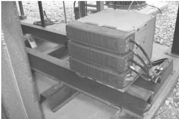
Para el caso de equipos con guía de onda tipo fibra óptica, los módulos de RF se instalan sobre la estructura en soportes adecuados para su montaje (esto aplica para el caso de Flexy Edge).
