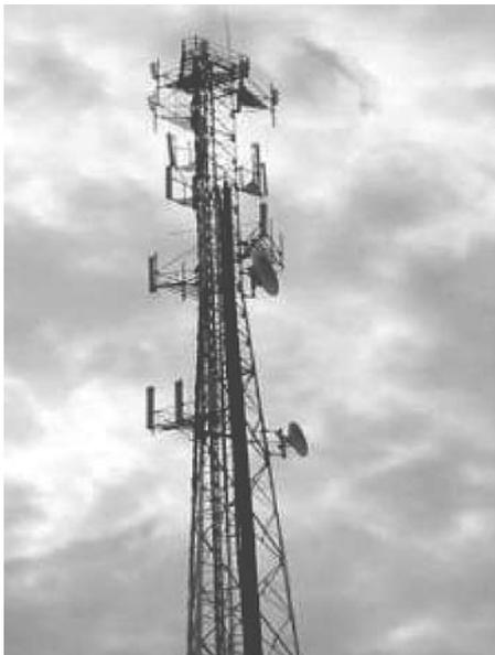
establecidas como escalerilla de ascenso, guaya para instalación de freno de caída y sus respectivos descansos dependiendo de la altura de la misma. Algunas ofrecen soportes para instalación de antenas y equipos.
