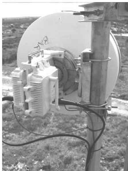
además proveen de alimentación a los equipos indoor de microondas. Estos equipos de energía por lo general son de un fabricante diferente al de los equipos de RF, pero son diseñados para esta aplicación.
